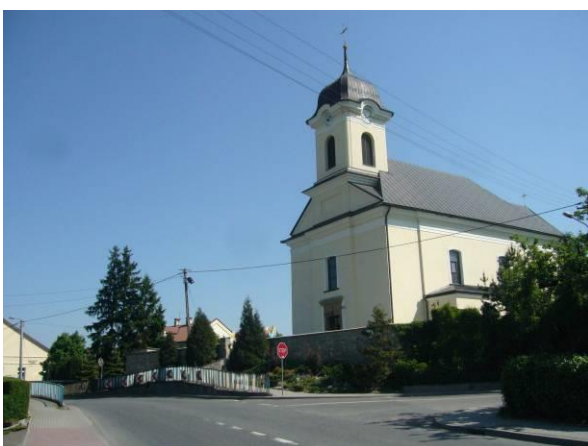
Fot. 17 Kościół parafialny p.w. Znalezienia Krzyża Świętego w Brzostku (A-91 z dnia 05.01.1968 r.) stoi w sąsiedztwie Rynku - od strony południowo - wschodniej. Otacza go kamienny mur z bramami od strony Rynku, plebani i ul. Łukasiewicza. Wzniesiony w 1817 r., murowany, neoklasycystyczny, jednonawowy. Do zamkniętego półkoliście prezbiterium przylega zakrystia i położony
