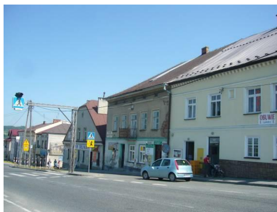
Fot. 74. Pierzeja przyrynkowa wschodnia w Brzostku z zabudową piętrową.
