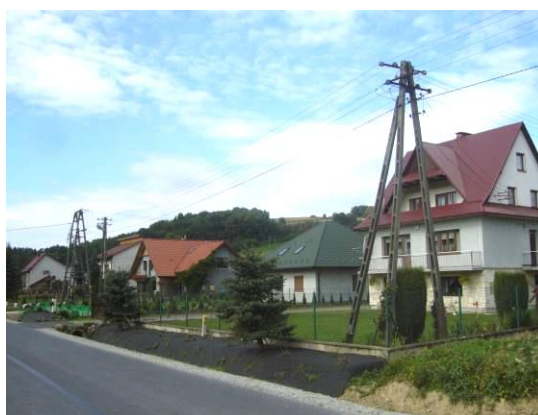
Fot. 7 Brak harmonii brył nowych budynków w Gorzejowej
