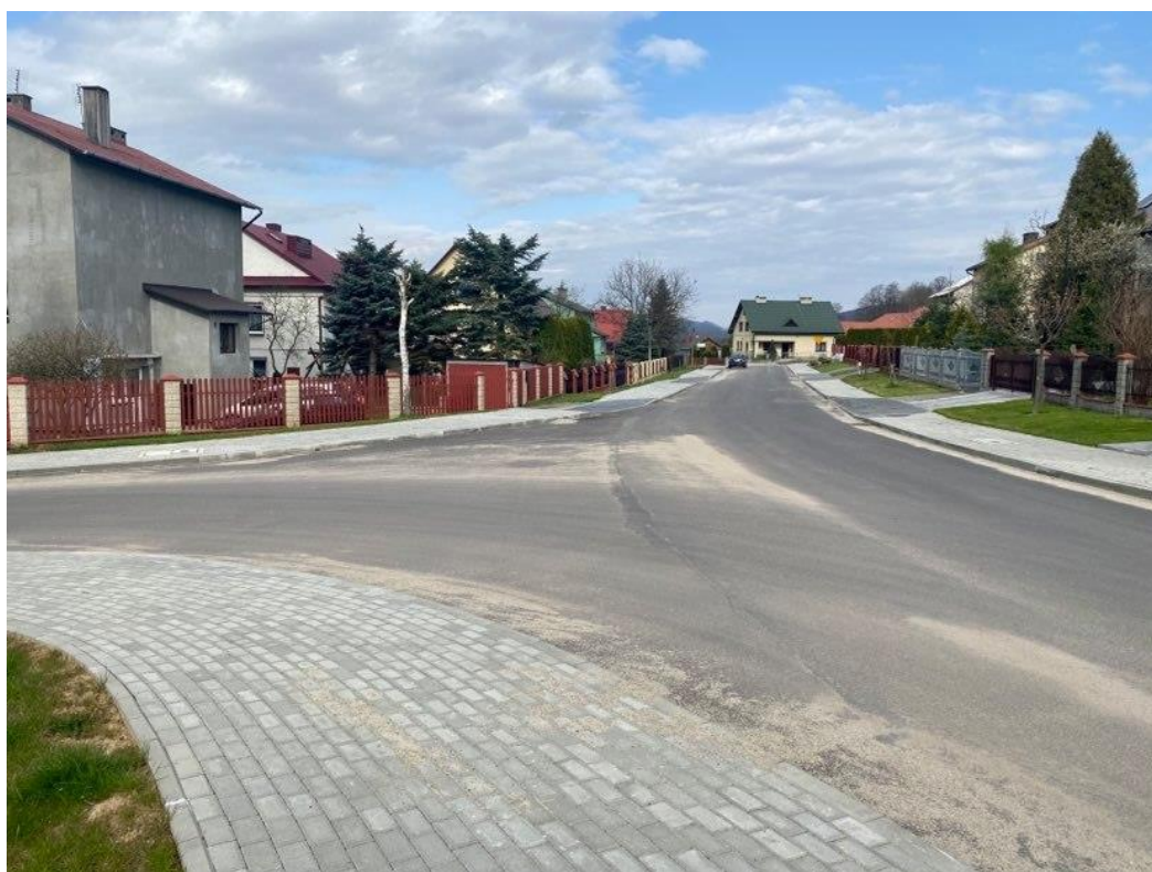
„Przebudowa dróg gminnych ul. Ks. Józefa Jałowego w km 0+000-0+277 i ul. Teodora Furgalskiego w km 0+000-0+162 w m. Brzostek”
