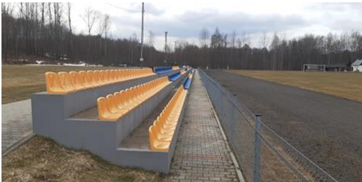
Przebudowa stadionu sportowego przy ul. Okrągłej w Brzostku
