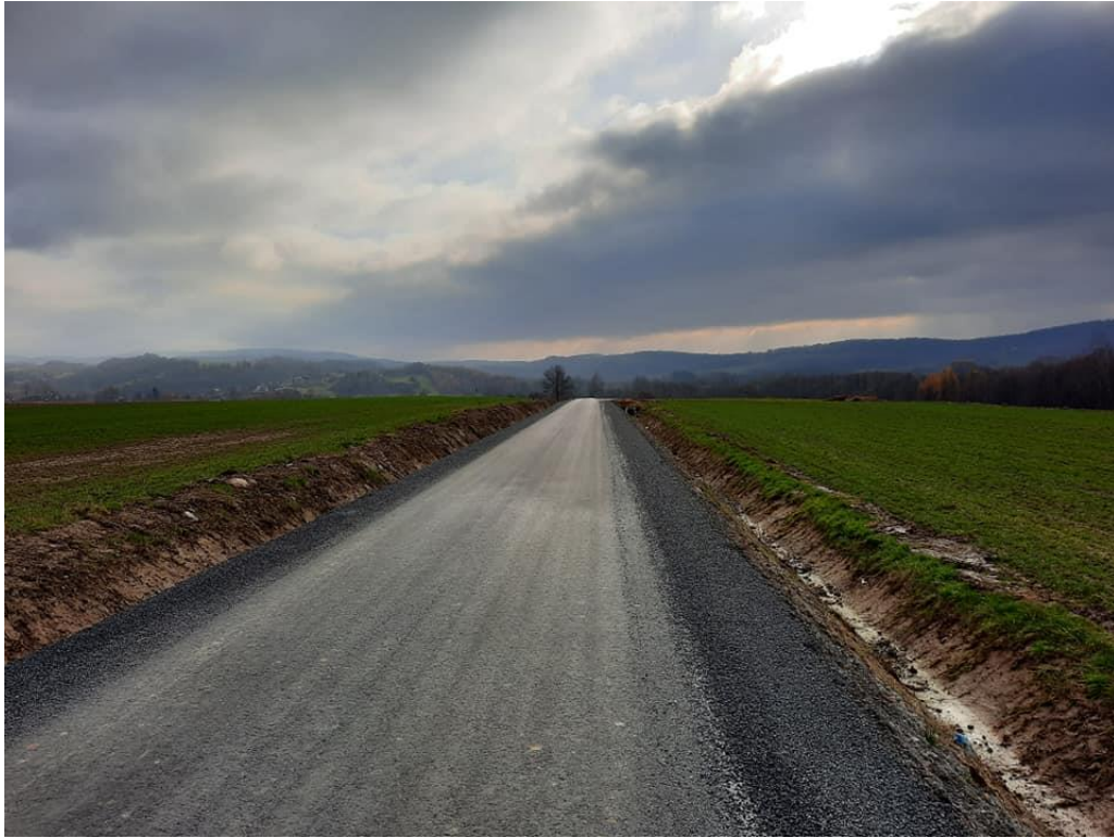
„Przebudowa drogi gminnej 106118 Głobikówka – Grudna Dolna w m. Grudna Dolna”
