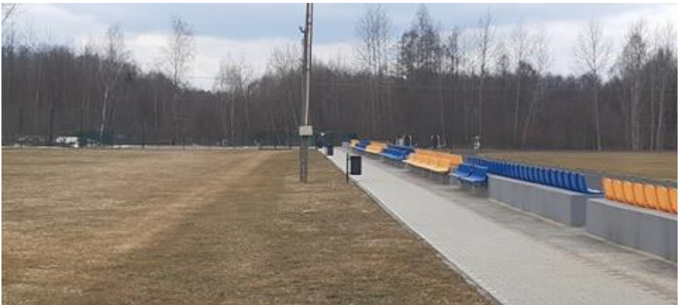
Przebudowa stadionu sportowego przy ul. Okrągłej w Brzostku
